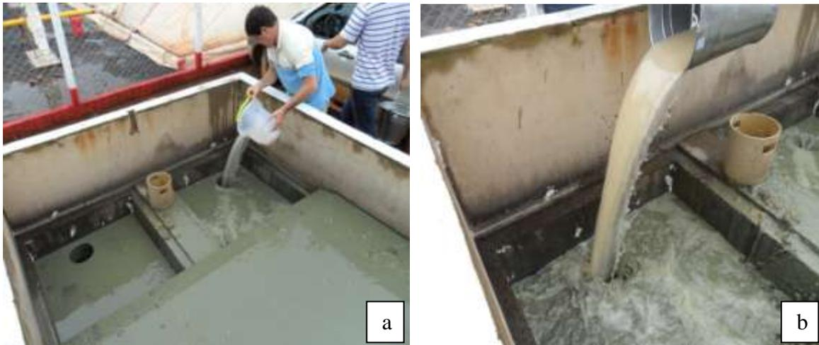
Figura 8 – Bactérias aplicadas no afluente (a) entrada do biodigestor 1; (b) entrada do biodigestor 2
