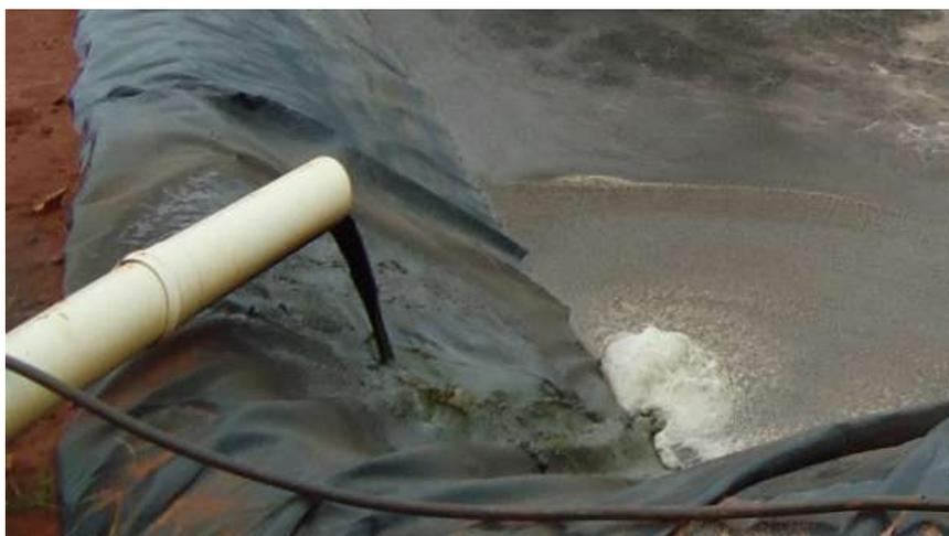
Figura 3 – Saída do biodigestor
